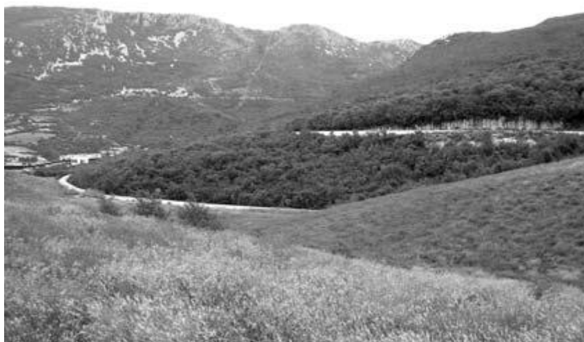
Slika 3 Današnji izgled saniranog odlagališta TE Plomin
