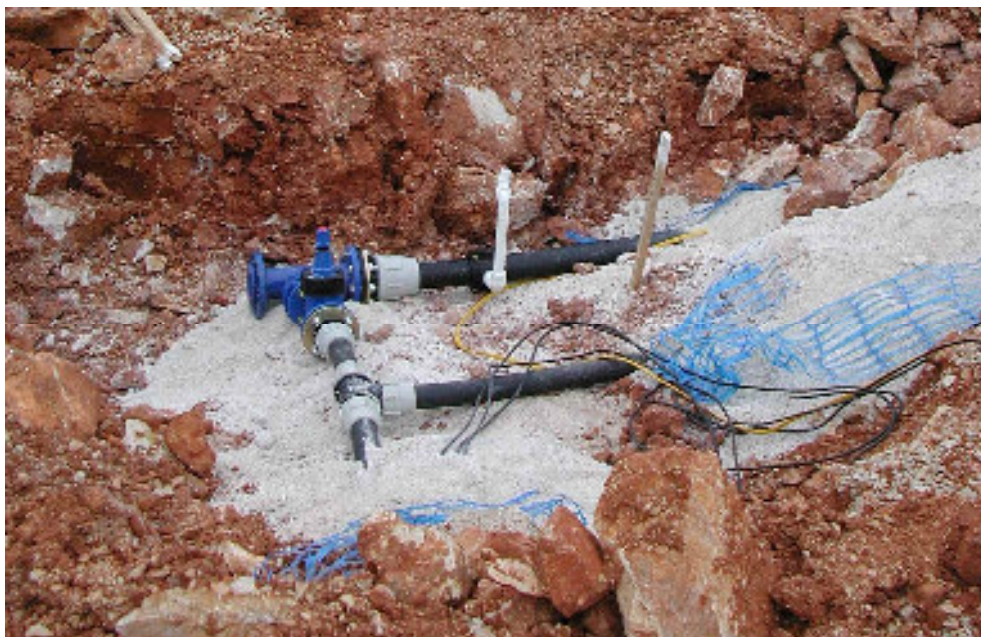
Slika A.4.2.2.11. Postavljanje cjevovoda na kamenitom tlu
