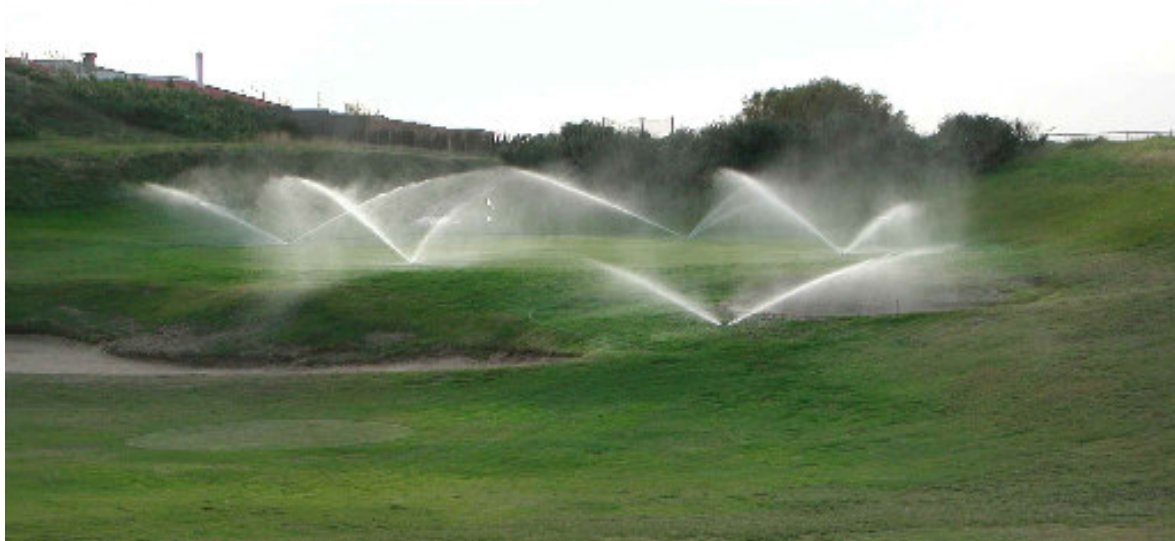
Slika A.4.2.2.13. Sustav za navodnjavanje; rad raspršivača na golf terenu
