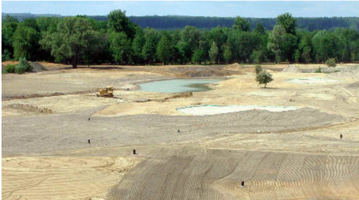
Slika A.4.2.2.3. Priprema tla za sadnju golf travnjaka
