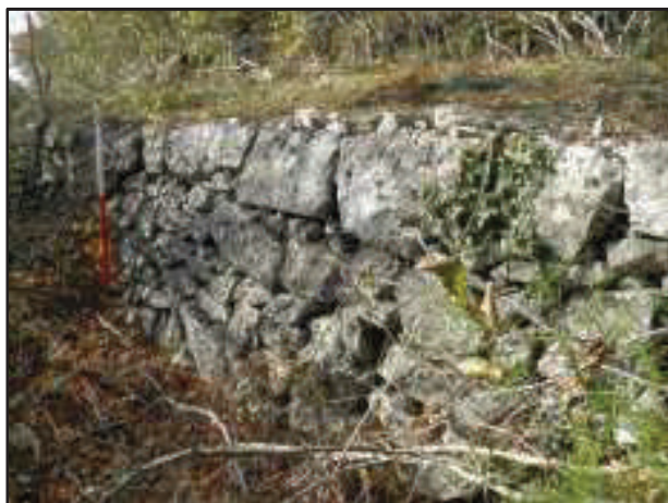
Slika 3.11.9. Kameni blokovi u podzidu ceste
