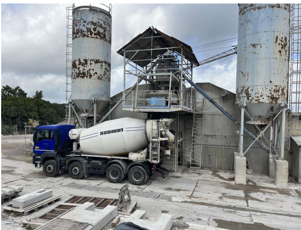
Slika 1.6 Silosi za cement Dubrove 1
