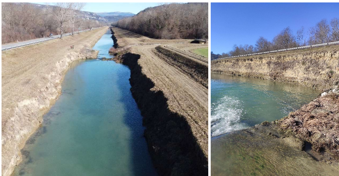
Slika 2-4 Lokacija 2 – pogled na predmetnu dionicu (lijevo) i erozija obale rijeke Mirne (desno) (izvor: Oikon)
