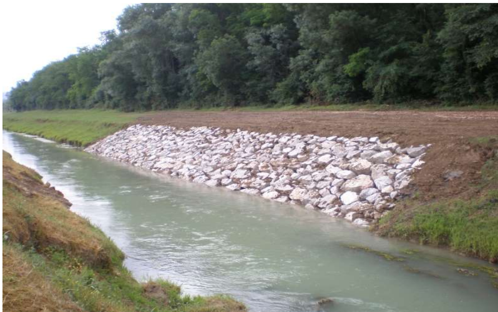
Slika 2-10 Planirani način sanacije pokosa obale (izvor: Hrvatske vode), neposredno nakon završetka radova
