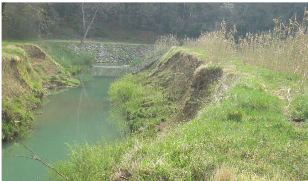
Slika 2-7 Lokacija 3 –erozija obale na predmetnoj dionici (izvor: Hrvatske vode)
