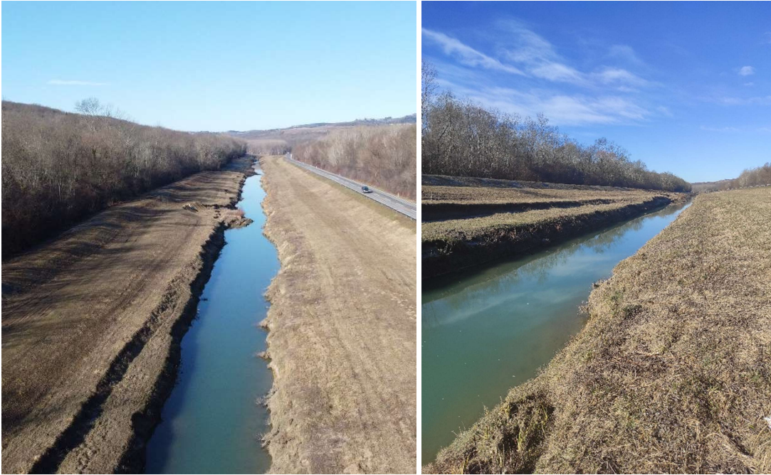
Slika 2-2 Lokacija 1 – pogled na predmetnu dionicu (lijevo) i erozija lijeve obale Mirne na lokaciji (desno) (izvor: Oikon)
