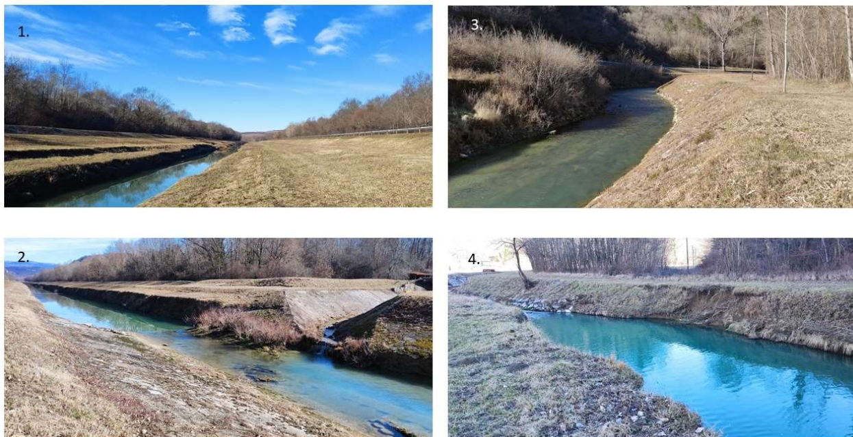
Slika 3-37 Prikaz obale rijeke Mirne na kojoj se planira provesti izgradnja obaloutvrde (1) km 17+446,00 do 17+496,00 (2) km 22+286,00 do 22+340,00 (3) km 28+320,00 do 28+370,00 (4) km 29+900,00 do 29+950,00 (izvor: Oikon d.o.o.)
