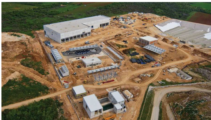
Slika br. 20: Izgradnja ŽCGO Kaštijun (G. Pula)
