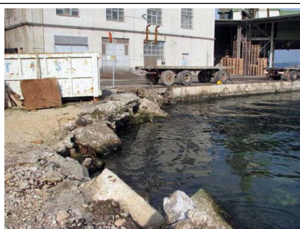
Sl. 3.2.5-17: Mediolitoral na području zahvata je crna crta na betonskoj i nasutoj podlozi
