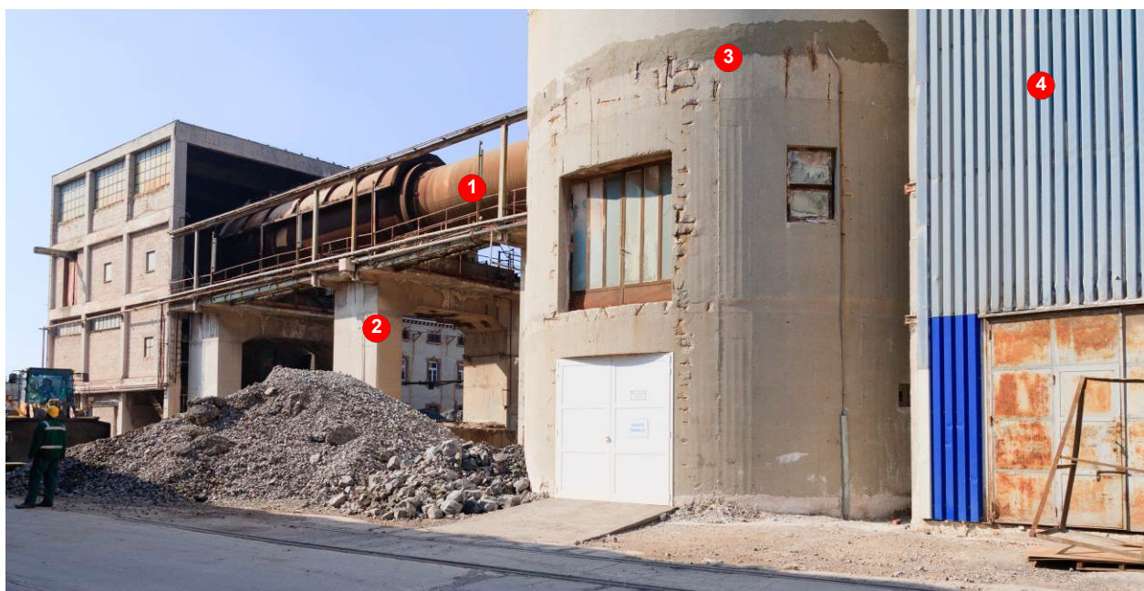
Sl. 4.10.2-1: Gore: Dijelovi linije proizvodnje/objekti predviđeni za uklanjanje Sredina: Pogled na postojeći tvornički krug s mora (sjeveroistok) Dolje: Pogled na proizvodnu linije iz tvorničkog kruga (južno pročelje)
