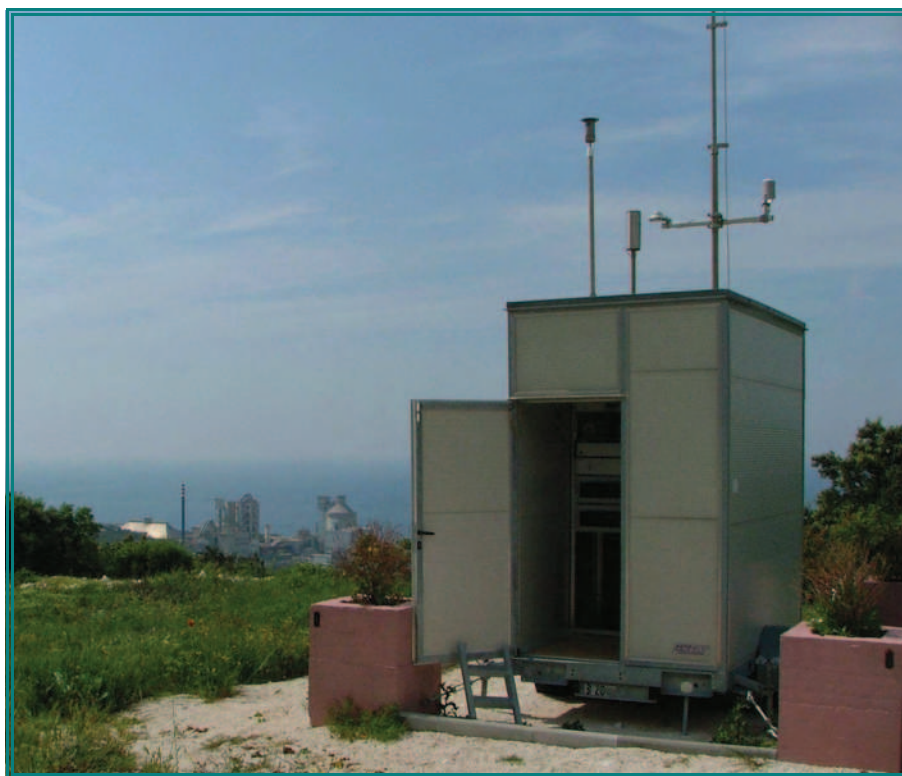
Slika 1c. Automatska mjerna stanica - A.P.Brovinje
