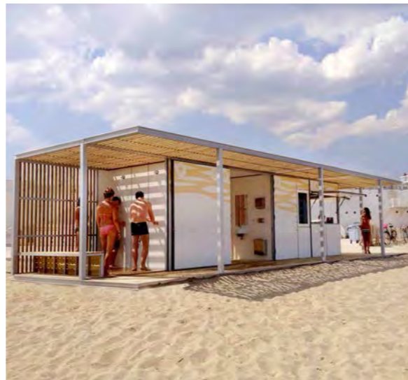
Slika 53: Primjer sanitarnog objekta
