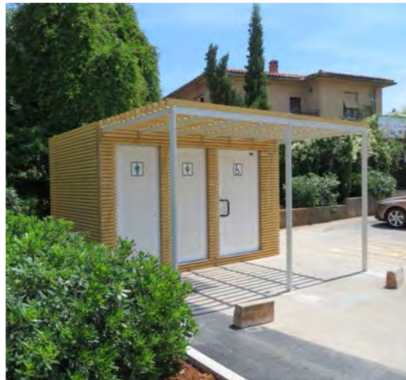
Slika 52: Primjer sanitarnog objekta
