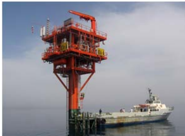
Slika 4.1.9. izgled tipične monopodne platforme za proizvodnju prirodnog plina
