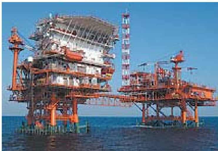
Slika 1.2.1. Proizvodna platforma Ivana A (lijevo) i kompresijska platforma Ivana K
