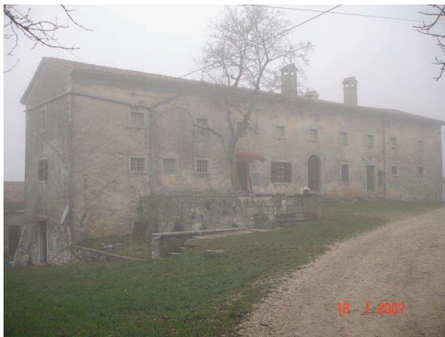
Gortanov Brijeg, Pazin – Zgrada budućeg Podcentra za održivi razvoj stočarstva, pčelarstva i zaštitu biološke raznolikosti Istre Pazin
