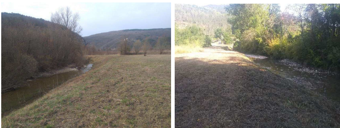
Pogled na dio bujice koji je zapunjen bujičnim nanosom
