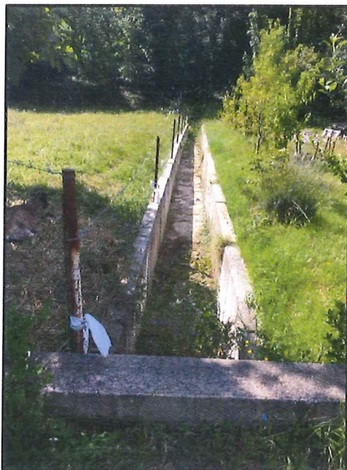
Slika 2.1-8. Prikaz lijevog kraka bujice Kapelice II koji se spaja na regulirano korito bujice (izvor: DUEL PROJEKT, 2018.)
