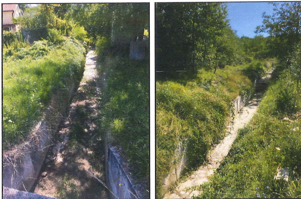
Slika 2.1-6. Prikaz korita reguliranog pravokutnim armirano-betonskim kanalom, pogled uzvodno (izvor: DUEL PROJEKT, 2018.)
