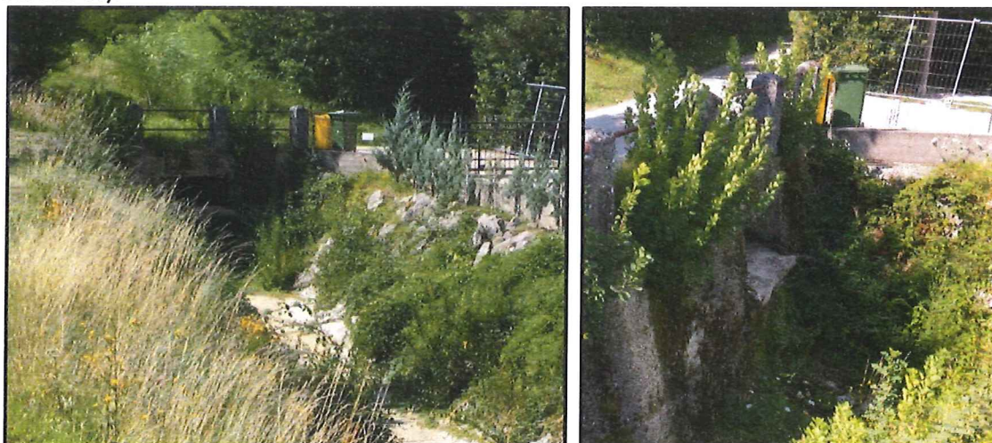
Slika 2.1-5. Prikaz propusta ispod nerazvrstane prometnice, pogled uzvodno (izvor: DUEL PROJEKT, 2018. )
