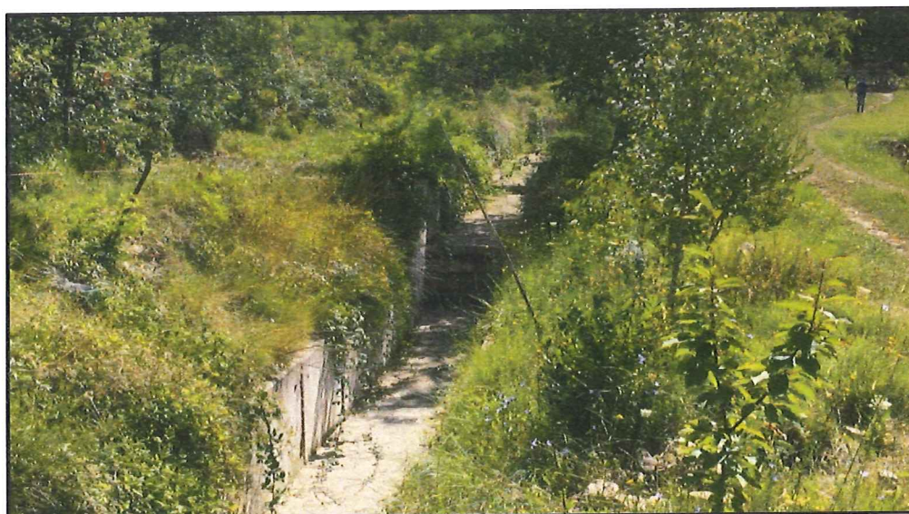
Slika 2.1-7. Prikaz hidrauličkih stepenica na reguliranom dijelu korita (izvor: DUEL PROJEKT, 2018.)
