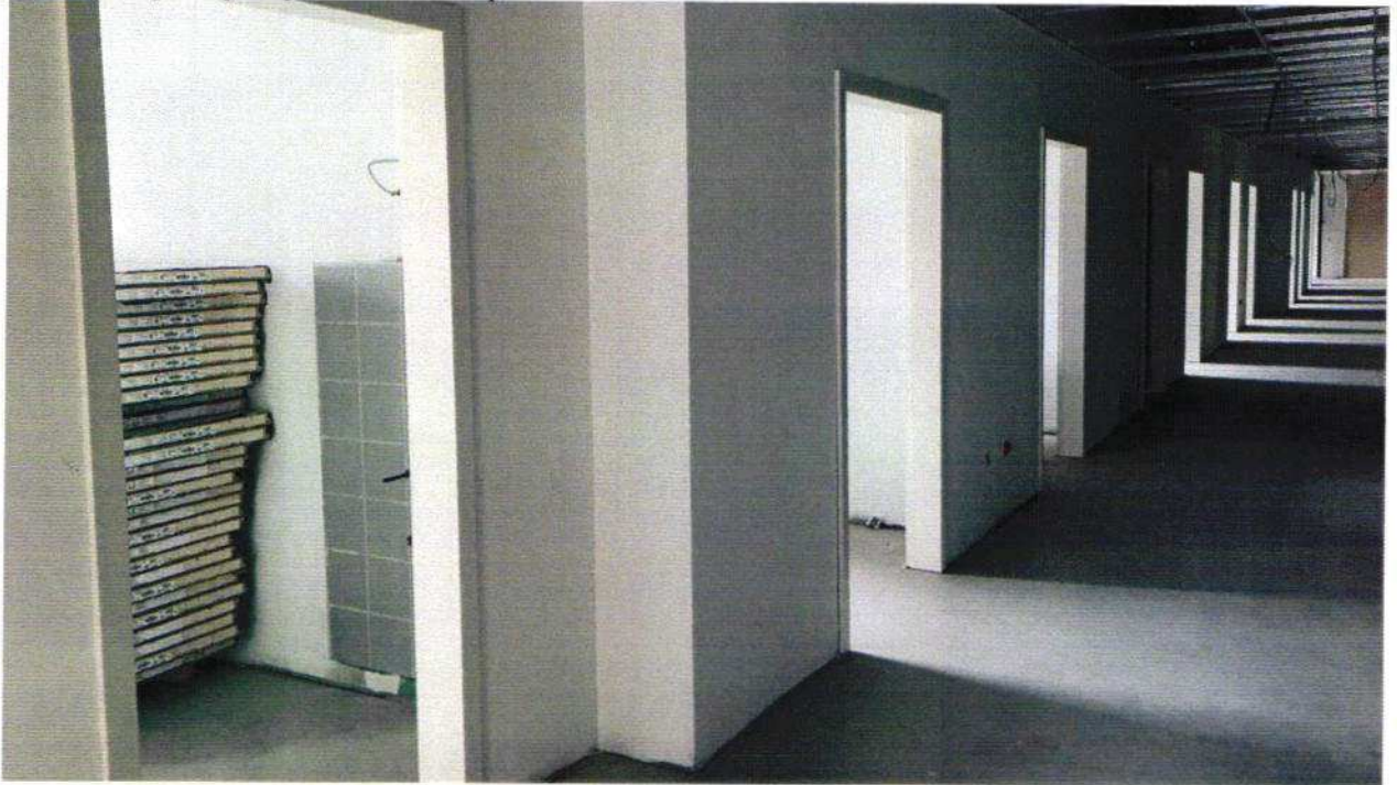
Slika 9. Pripremljeni pod hodnika za postavu linoleuma
