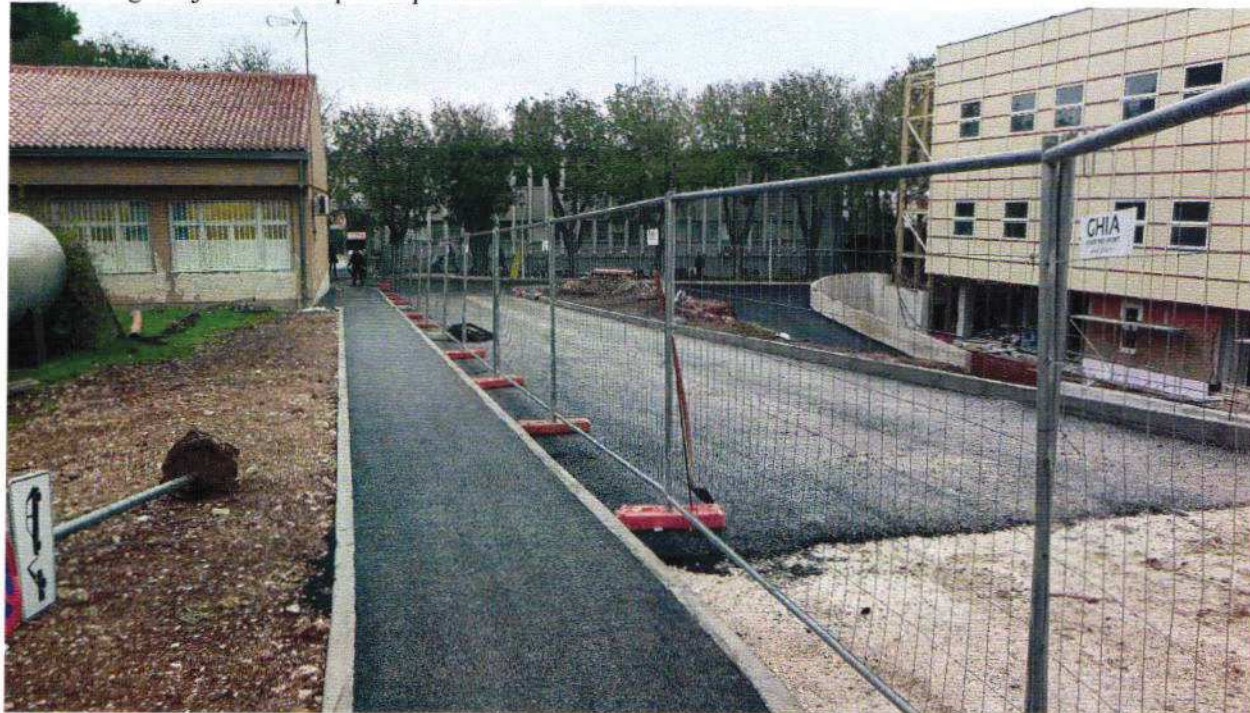
Slika 5. Ugradnja BNS-a zapadna prometnica
