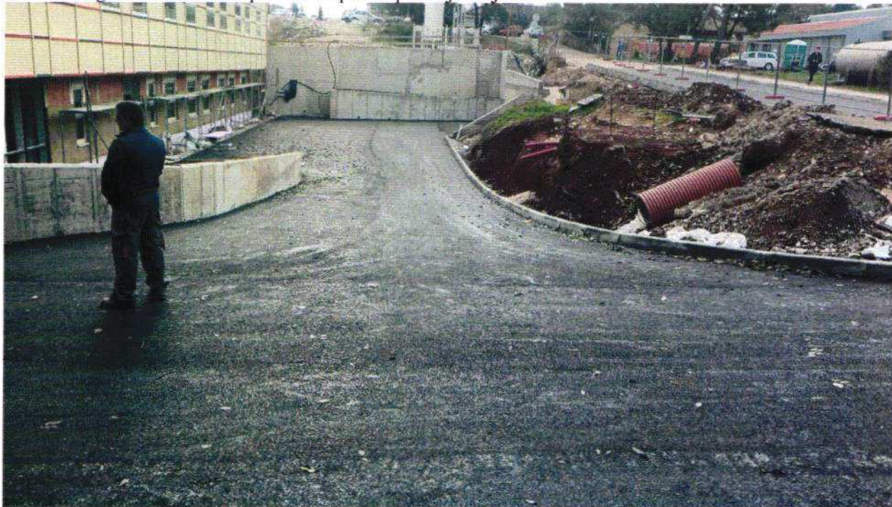
Slika 7. Pogled na asfaltirani plato uz zapadno pročelje Objekta 2.
