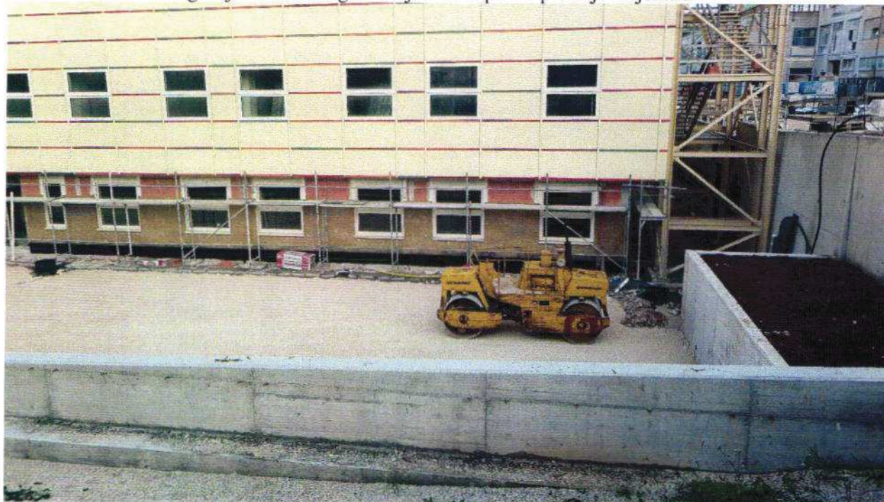
Slika 3. Izrada nosivog sloja od kamenog materijala uz zapadno pročelje Objekta 2
