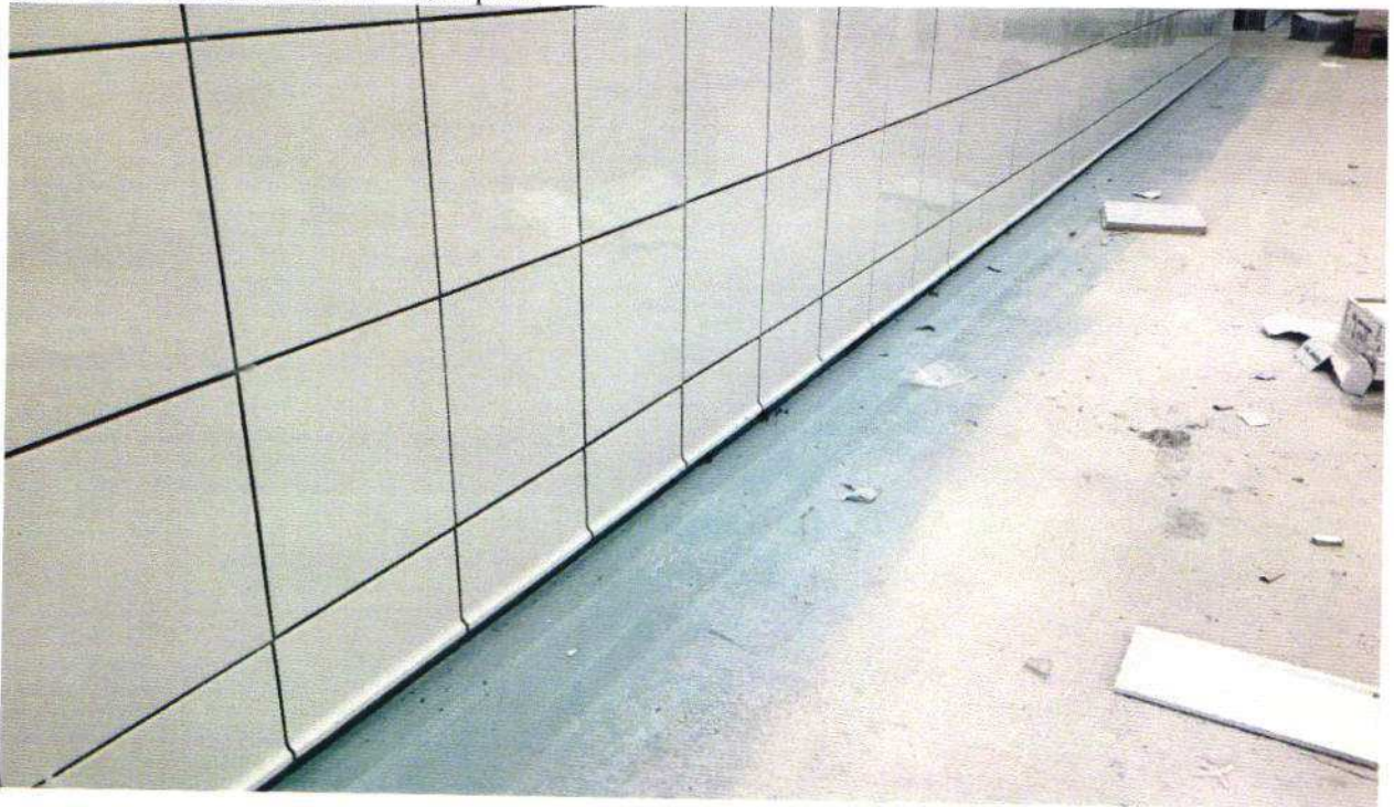
Slika 8. Keramičarski radovi - sokl poda
