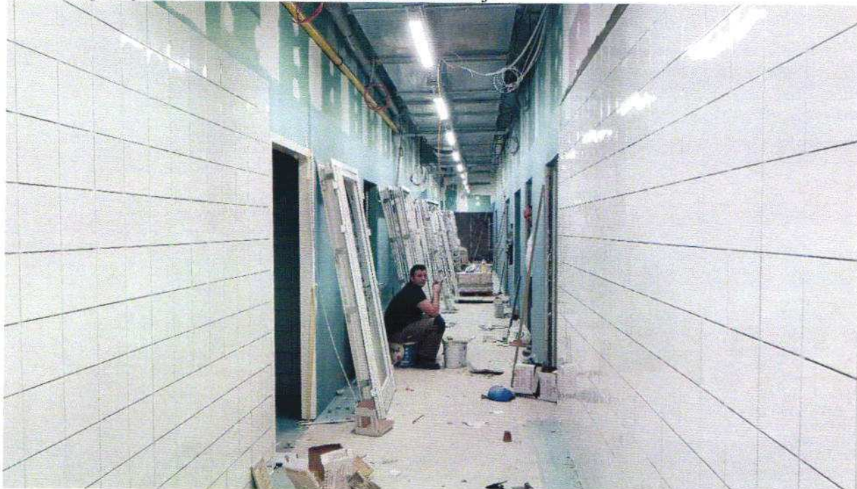
Slika 1. Ugradnja keramike i dovratnika u hodnicima kuhinje
