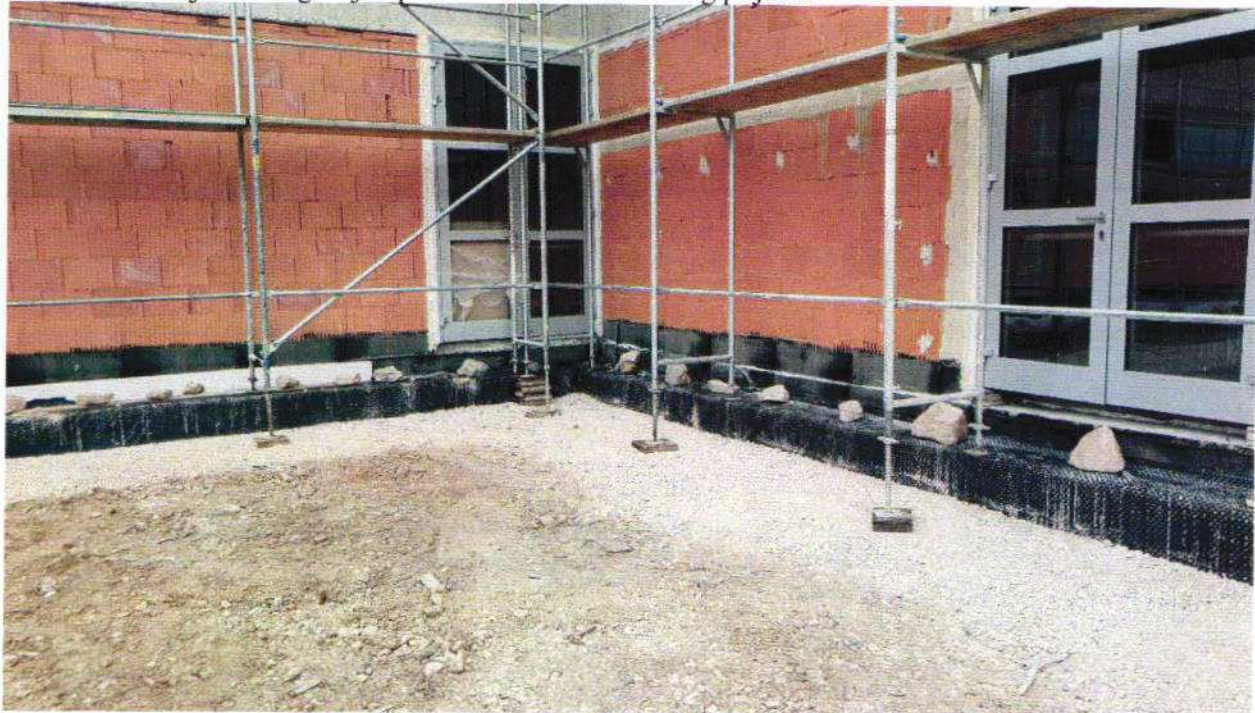
Slika 5. Uređenje nosivog sloja i postava skele u zoni hitnog prijema
