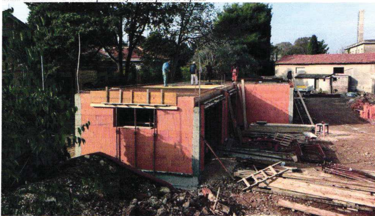
Slika 8. Izrada AB krovne ploče objekta za prihvat otpada
