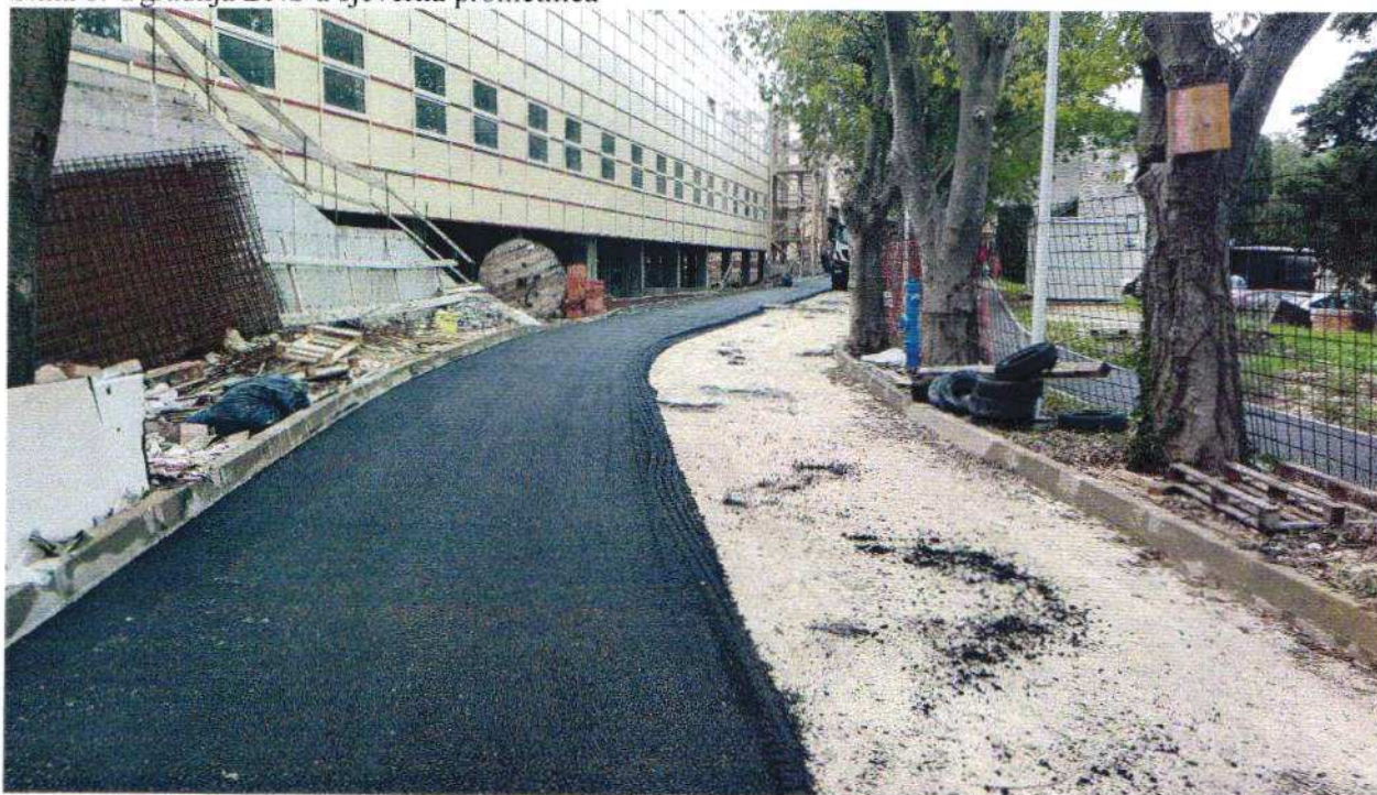
Slika 6. Ugradnja BNS-a sjeverna prometnica
