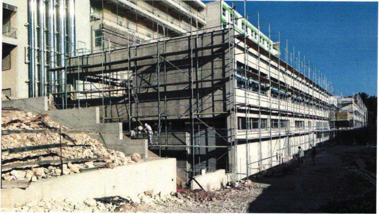
Slika 7. Pogled na južno pročelje s gospodarske prometnice – postavljena skela
