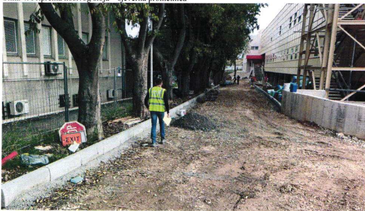
Slika 4. Priprema nosivog sloja – sjeverna prometnica
