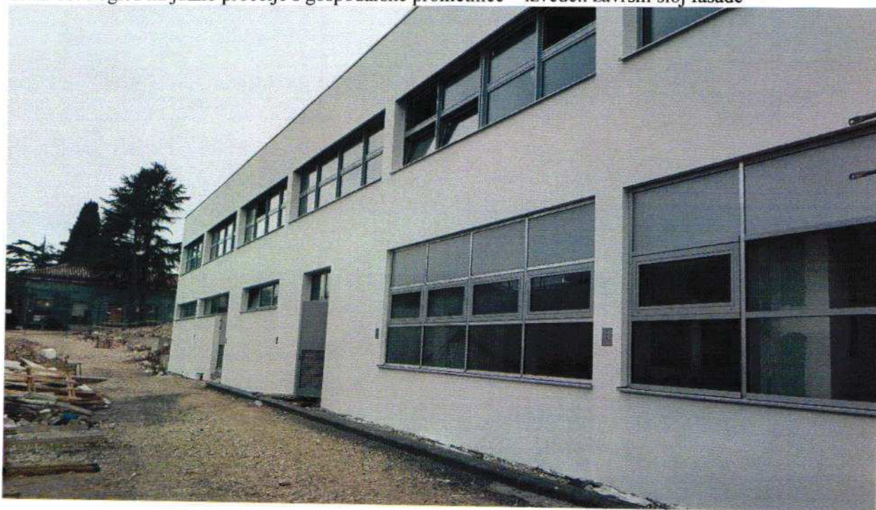
Slika 10. Pogled na južno pročelje s gospodarske prometnice – izveden završni sloj fasade
