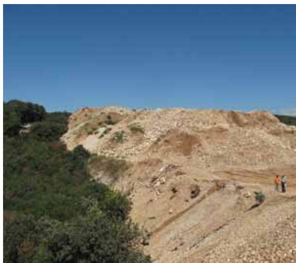
Slika 14: II i III radna etaža. Kosine formirane slob.padom
