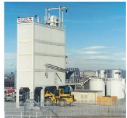
Slika A5.2. Asfaltna baza Benninghoven kontejnerskog tipa
