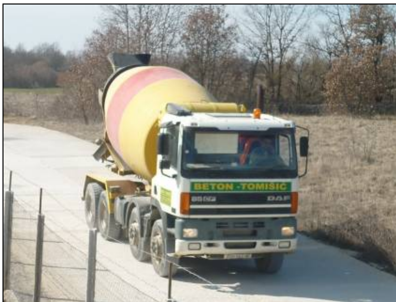
Fotografija A.4.: Prometnica je izgrađena, asfaltirana i redovito se održava
