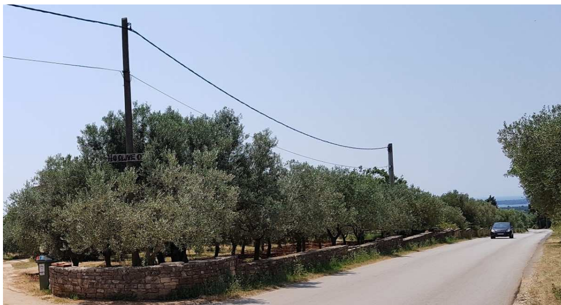
Slika 4-68 – Fažanska cesta (Ž5192) i dalekovod
