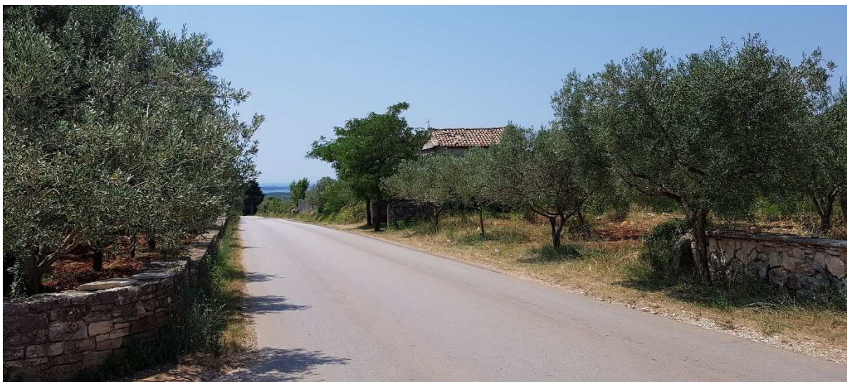
Slika 4-50 - Vizura V3 – pogled iz dvorišta stambenog objekta prema kapelici i lokaciji planiranog zahvata na sjeverozapadu
