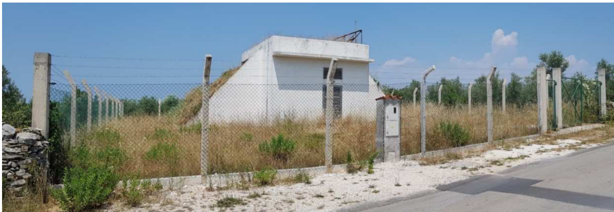
Slika 4-64 – Prekidna komora magistralnog vodoopskrbnog cjevovoda jugoistočno od zahvata
