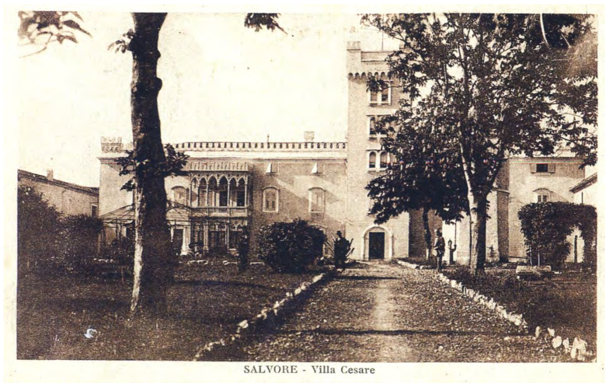
Slika 38. Pogled na južno pročelje prije 1926. godine.
