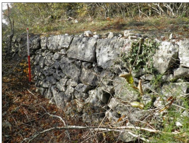
Slika 3.11.9. Kameni blokovi u podzidu ceste
