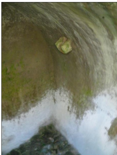
Slika 3.11.14. Pogled na slivni kanal i ožbukanu unutrašnjost
