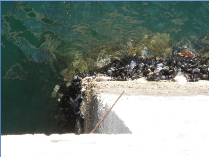
Slika 88. Obraštaj na betonskoj rivi na otoku Sv. Katarina, mediolitoral – pojas plime i oseke, dominiraju rakovi vitičari i dagnje
