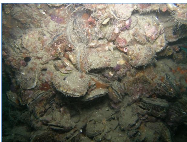
Slika 103. Brojno naselje jadranskih kamenica ( Ostrea edulis ) i drugih organizama na betonskom dijelu mosta, dubina oko 2 m
