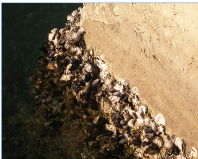
Slika 101. Debele naslage alohtonih školjkaša vrste Crassostrea gigas (pacifička kamenica) i dagnji na betonskoj rivi na otoku Sv. Katarina, zona plime i oseke
