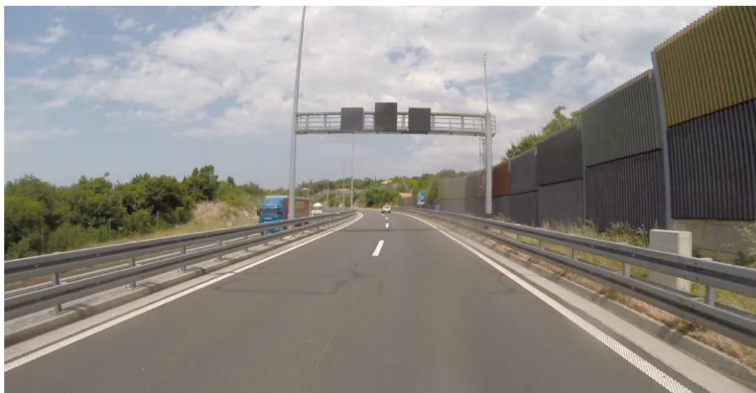
Slika 102. Svjetlosna prometna signalizacija u funkciji regulacije prometa na obilaznici Rijeke
